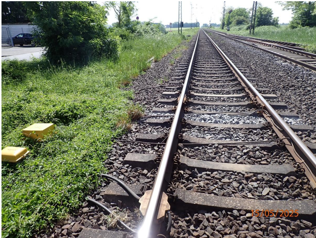
Bild 5: Achszähler und Isolierstöße km 28,697
