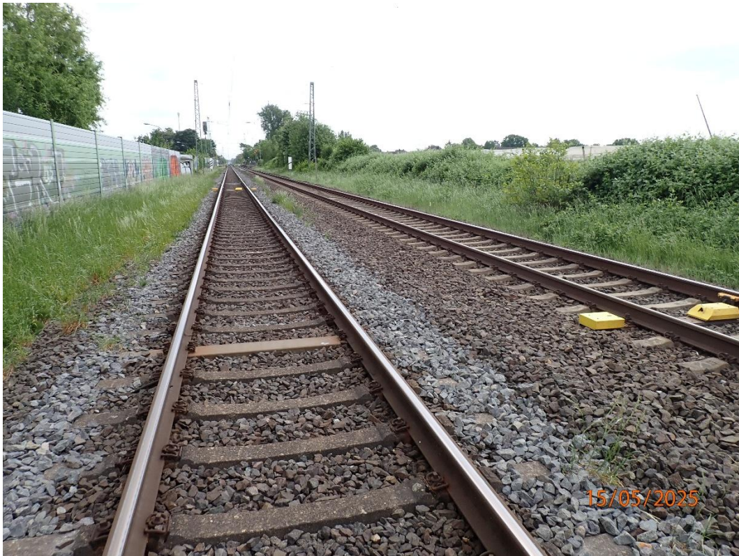
Bild 19: Hohlschwelle, km 24,556
