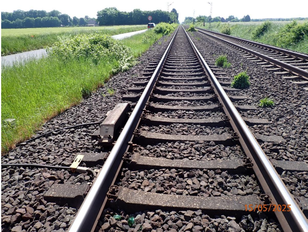
Bild 7: PZB-Magnet und Ende Schienenfußkabel km 28,231
