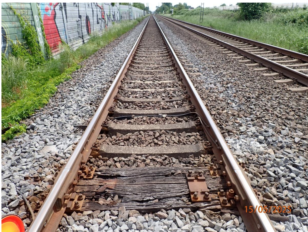
Bild 18: Isolierstöße und Kuppelstoß, km 24,728
