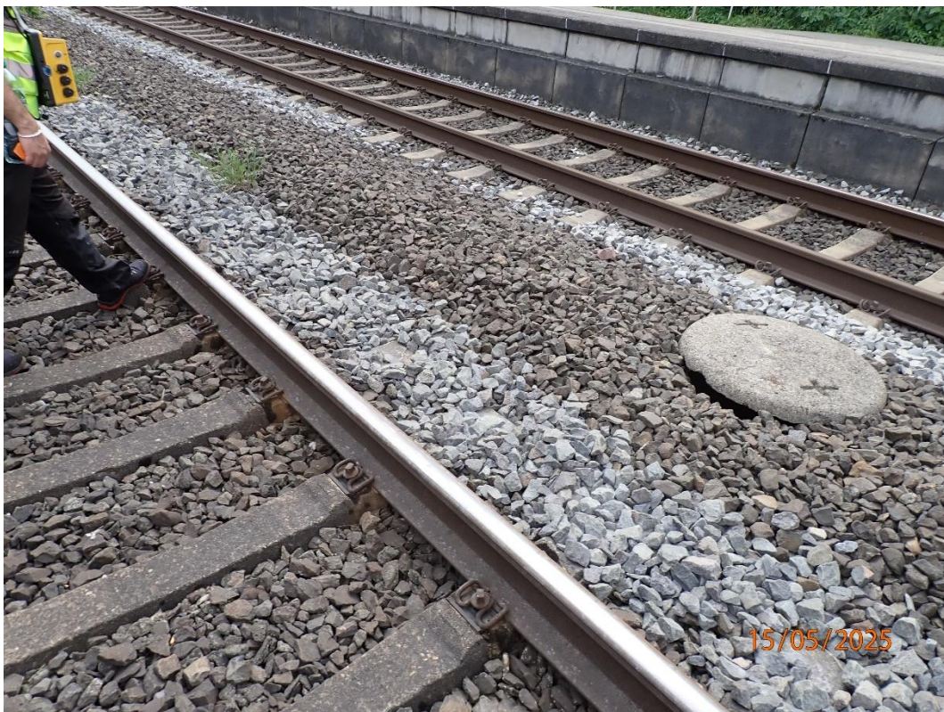
Bild 22: Entwässerungsschacht km 24,315
